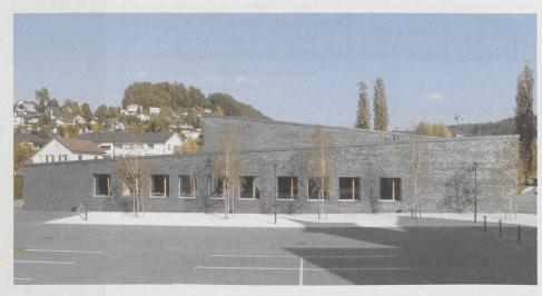
1 Die beiden geneigten Dächer steigen mit vier Grad an - der minimal vorgeschriebenen Neigung. Die Rückwand der Turnhalle nimmt diese Schräge ebenfalls auf. Fotos: René Rötheli
