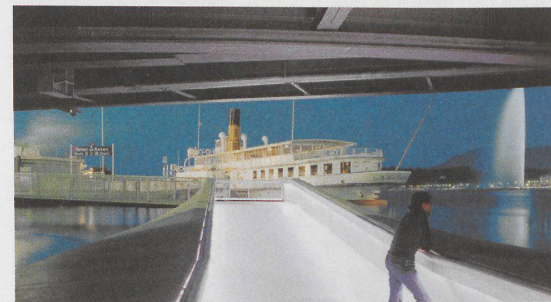
2 Unter der Brücke kippt die Reling aussen immer mehr in die Horizontale, gleichzeitig verjüngt sich der Durchgang auf 2,5 Meter: eine Raumzentrifuge.
