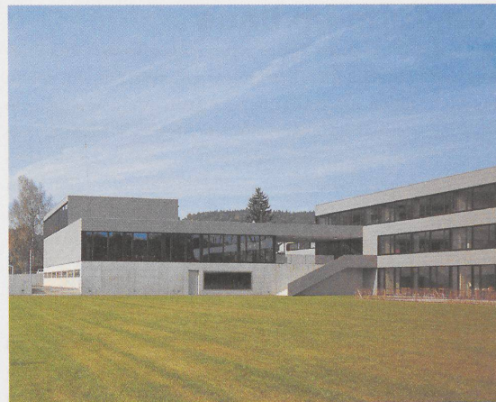
1 Die Betondecke und der Boden aus Hartbeton führen aus dem Innern des Foyers nach aussen und verbinden die Mehrzweckhalle mit dem Schulhaus. Fotos: Heinrich Helfenstein
