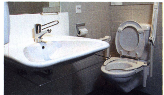
2 Beim Behinderten-WC wird das Neueste geboten: höhenverstellbare Einrichtungen.
