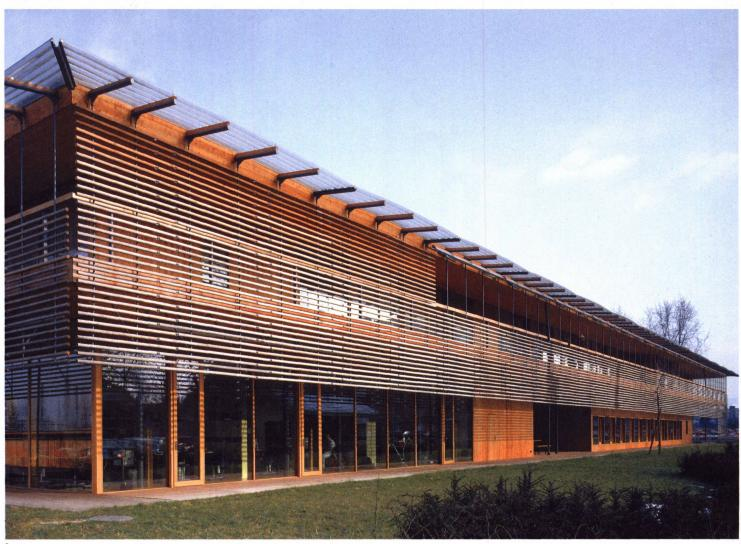
turen aus runden Hölzern, manchmal horizontal als Gewebe, an anderen Orten vertikal in den Boden gesteckt, sind Brüstungen, führen textile Sonnenstoren oder dienen wie ein Paravent als Sichtschutz. Diese Holzprofile sind mit Dübeln aus Plexiglas verbunden, die im entprechenden Licht wie Leuchtkugeln schimmern.
