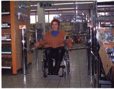
24 Coop ist bereits so weit: Die Eingangsschleuse ist optisch gesteuert und öffnet sich automatisch.
