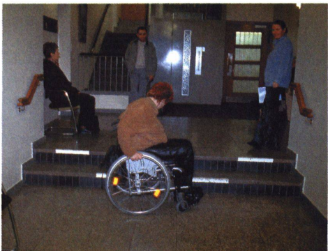
41 Zum Büro für IV-Bezüger führen zwei Stufen, der Lift ist zu eng: selbst bei Gemeindehäusern kein Einzelfall.
