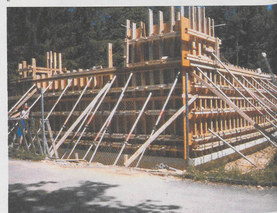
3 Die Wand-, Boden- und Deckenschalung wurden gleichzeitig montiert, sodass das Pumpwerk in nur einem Tag gegossen werden konnte.
