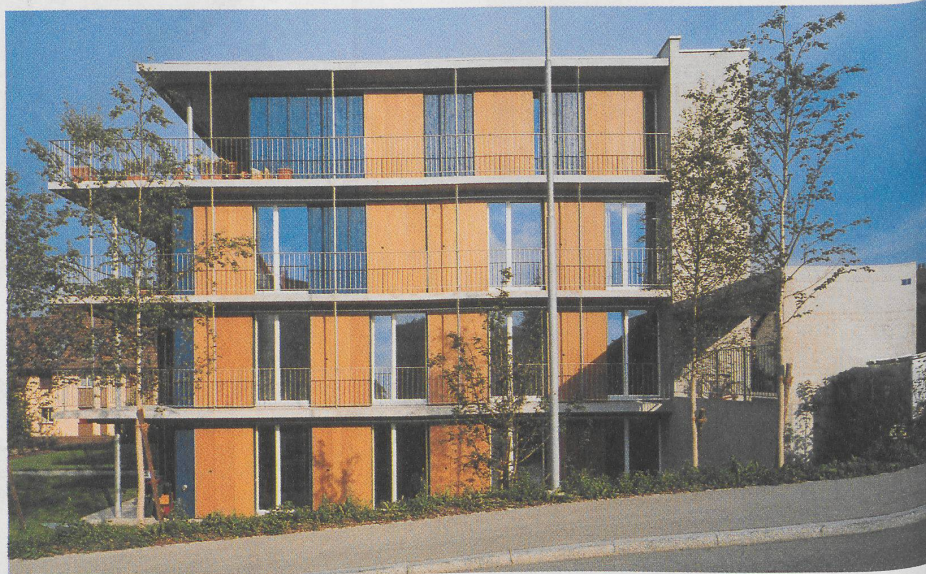
1 Zwischen die auskragenden Sichtbetondecken sind dunkelblaue Dreischichtplatten und Holzschiebeläden eingespannt.
