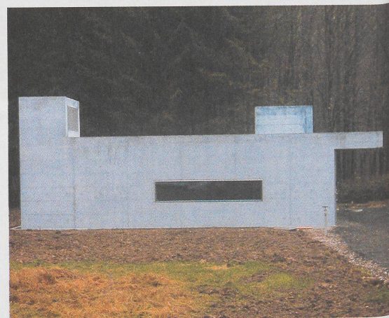
1 Oben Betriebsraum mit Lager und Arbeitsplatz hinter der Fensterscheibe, unten Maschinenraum für die Pumpen
