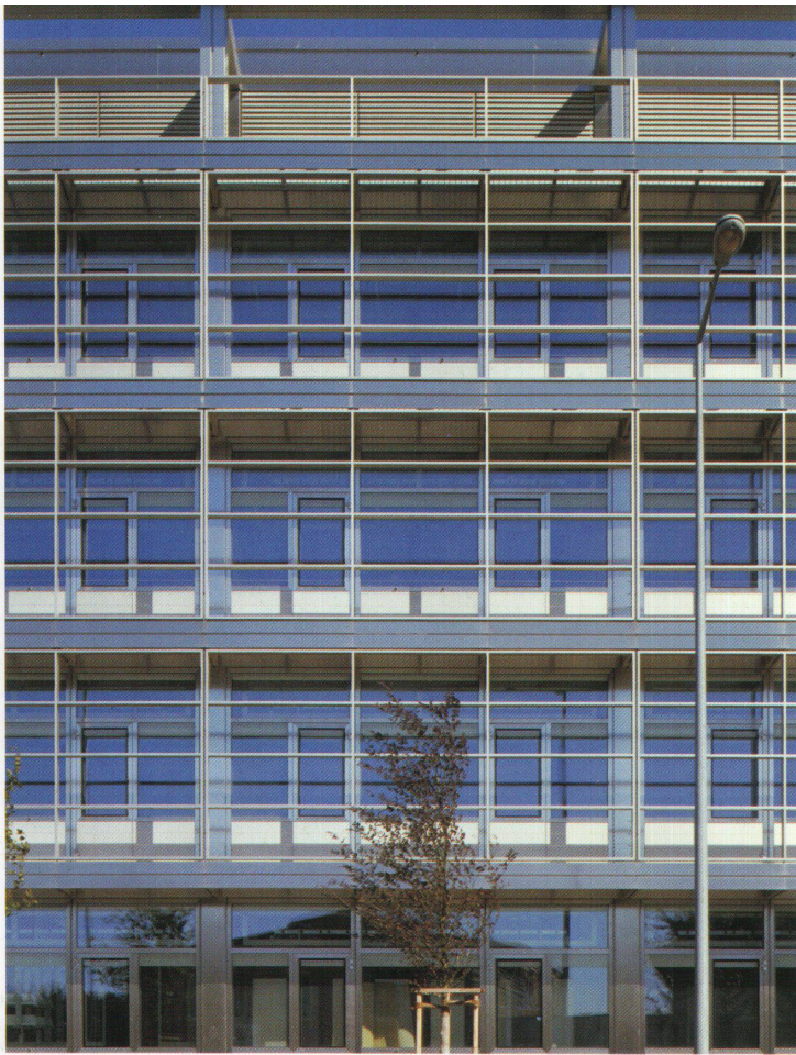
Mit einem Grundelement lassen sich alle nötigen Fassadentypen herstellen. Hier jene mit Fluchtbalkon vor den Laboratorien
