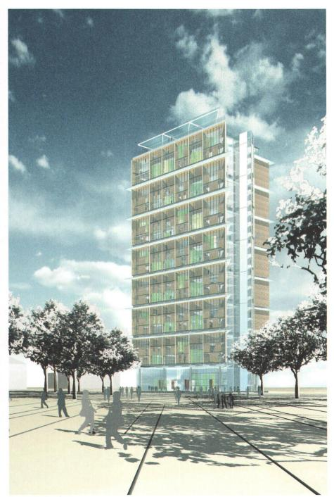
In einem Hochhaus aus Holz muss nach jedem dritten Geschoss ein Brandabschnitt eingefügt werden. Dieser prägt die äusserliche Erscheinung, bestimmt jedoch auch die Tragstruktur: Im Rhythmus der Brandabschnitte werden dreigeschossige Reihenhäuser – Wohnungen gegen Süden, Büros gegen Norden – eingebaut.
