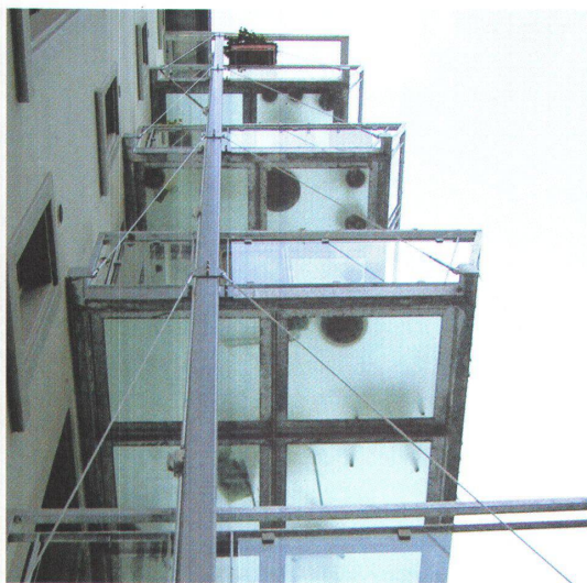
1 Die Glasböden der Balkone lassen genügend Licht in die darunter liegenden Küchen.
