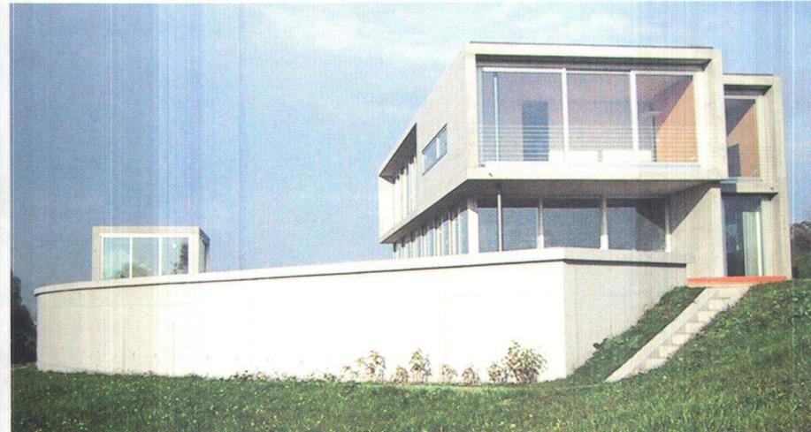
**1** Eine Betonwand verläuft dem Hang entlang und hebt das Grundstück von der Umgebung ab. Das Obergeschoss steht auf dünnen Stützen über dem Erdgeschoss.
