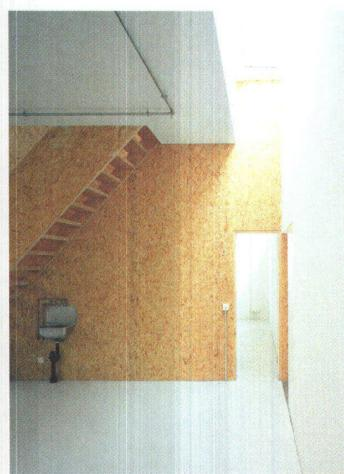
1 Die Ateliers sind innen ganz weiss, nur die Wand mit der Treppe aus OSB-Flachpressplatten vermittelt eine Materialstimmung. Türen am Rand ergeben Enfiladen durch die Ateliers. Fotos: Dominique Uldry
