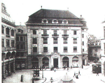
Volksbank Hauptsitz Basel: ein früher Beton-Ständerbau, ausgefacht mit Wackenmauern und verkleidet mit Savonnières-Kalk.
