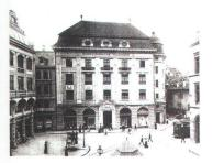
Volksbank Hauptsitz Basel: ein früher Beton-Ständerbau, ausgefacht mit Wackenmauern und verkleidet mit Savonnière-Kalk.
