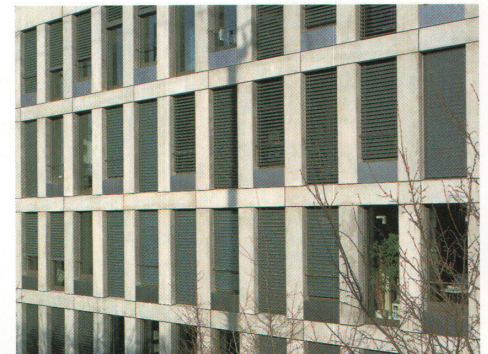
Der Glasanteil der Fassaden beträgt rund 50 Prozent
