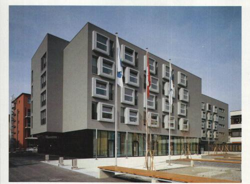
Die Baukörper der Bettengeschosse stehen auf dem verglasten Eingangsgeschoss. An Stelle von Balkonen, welche die Pflegebedürftigen erfahrungsgemäss nur wenig benützen, bilden aus der Fassadenebene gestülpte Fenster einen fliessenden Übergang von innen nach aussen
