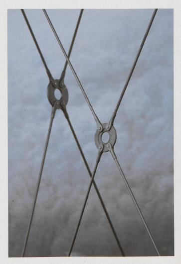
Die scheinbar leichtfüssigen Galets auf der Arteplage Neuenburg wiegen insgesamt 1400 Tonnen. Um die beschädigte untere Membran des Galets 3 (links) zu ersetzen, sind aufwändige Gerüste notwendig
