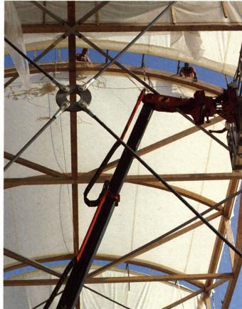
Das Hochamt des Holzes wird auf der Arteplage von Biel eingerichtet – Wege, Stege, die Plattform, die Ikone demonstrieren das konstruktive Können der Holzbauer. Bei der Montage der vorgefertigten Teile mit dem schweren Pneukran passierte ein Unglück – die Plattform trug die Punktlast nicht. Der Schaden ist behoben, der Bau kommt voran
