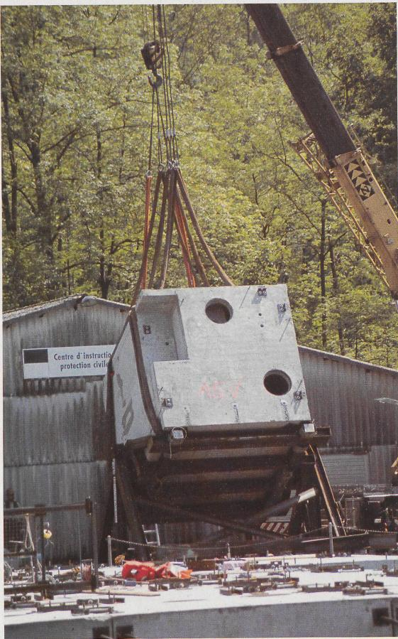
Der Montageplatz im Broyekanal bei Sogiez ist eine Grossbaustelle mit allen Schikanen. Der eigens konstruierte Drehbock funktioniert wie eine Waage: Wird er beladen, schwingt er um die eigene Achse und kippt den Betonquader senkrecht ins Wasser. Der Kran bremst die Dreissig-Tonnen-Klötze
