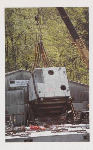
Der Montageplatz im Broyekanal bei Sugiez ist eine Grossbaustelle mit allen Schikanen. Der eigens konstruierte Drehbock funktioniert wie eine Waage: Wird er beladen, schwingt er um die eigene Achse und kippt den Betonquader senkrecht ins Wasser. Der Kran bremst die Dreissig-Tonnen-Klötze
