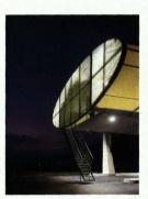
Nachts wirkt die Erdgastankstelle in Vaduz wie ein Ufo. Durch den Gitterrost an den Stirnseiten zeichnen sich die Anlagen ab, die das Gas auf 200 bar verdichten
