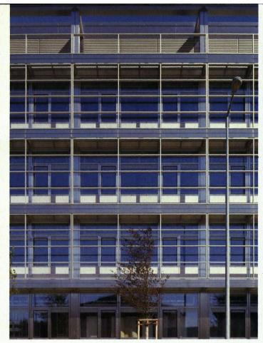
Mit einem Grundelement lassen sich alle nötigen Fassadentypen herstellen. Hier jene mit Fluchtbalkon vor den Laboratorien
