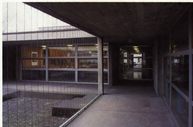
Der Eingang zum Pavillon ist mit gespannten Drähten gesichert
