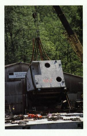
Der Montageplatz im Broyekanal bei Sugiez ist eine Grossbaustelle mit allen Schikanen. Der eigens konstruierte Drehbock funktioniert wie eine Waage: Wird er beladen, schwingt er um die eigene Achse und kippt den Betonquader senkrecht ins Wasser. Der Kran bremst die Dreissig-Tonnen-Klötze
