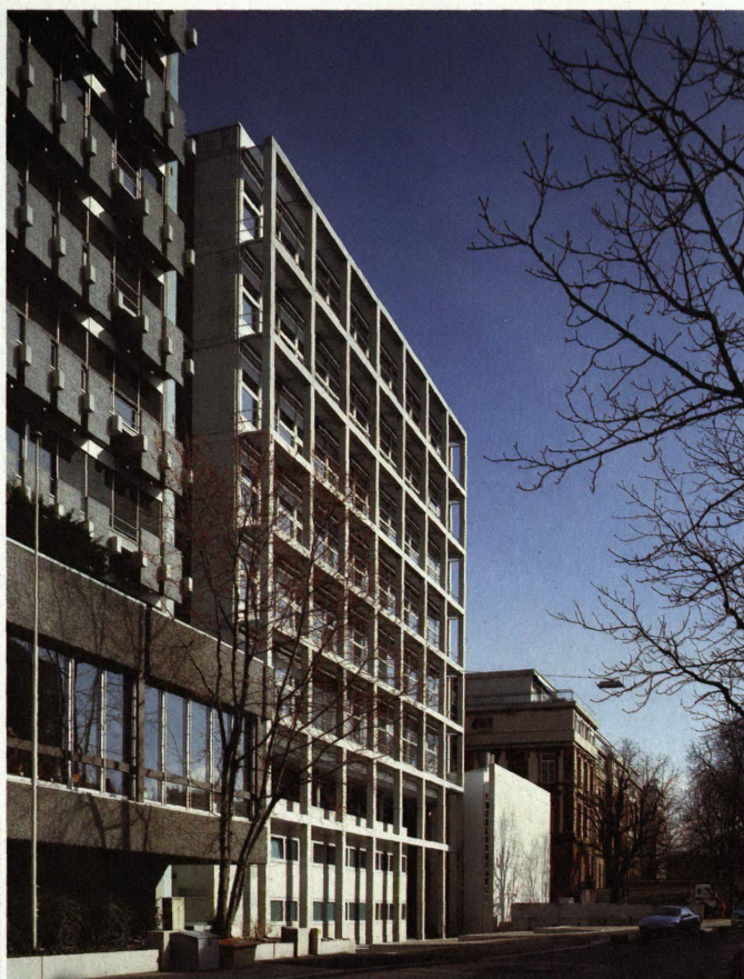
Das Betongitter prägt das Äussere des Pharmazentrums der Universität von Andrea Roost an der Klingelbergstrasse. Das Gitter verweist auf das Raster der Labornutzung. Die Verschiebung der Rastersysteme gegeneinander verstärkt die plastische Wirkung der Fassade
