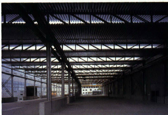
Das Freilager überspannt ein sheddachartiges Stahlleichttragwerk, die Profilbleche der Dachhaut stabilisieren gleichzeitig das Tragwerk. Die Entwässerung ist in den Fachwerken integriert
