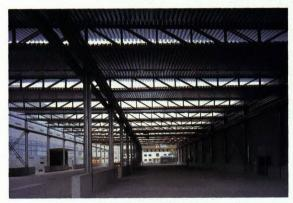
Das Freilager überspannt ein sheddachartiges Stahlleichttragwerk, die Profilbleche der Dachhaut stabilisieren gleichzeitig das Tragwerk. Die Entwässerung ist in den Fachwerken integriert
