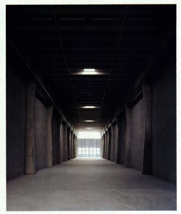
Das im Querschnitt 10 x 10 m grosse, tunnelartige Bobinenlager besteht vollständig aus vorgefertigten Betonelementen, darüber liegen Rippenplatten als Dach
