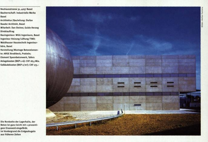
Die Nordseite der Lagerhalle, der Beton ist ganz leicht mit 1-prozentigem Eisenoxid eingefärbt. Im Vordergrund die Erdgaskugeln aus früheren Zeiten
