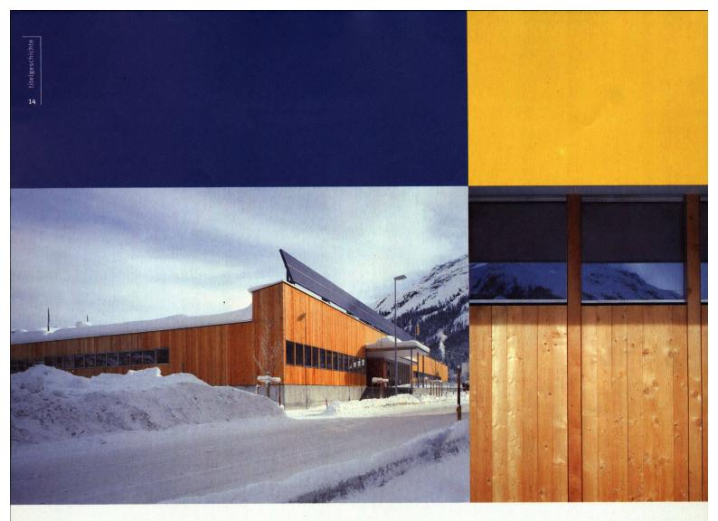
Eine über dem südlichen Eingangsbau schwebende 180 m² grosse Photovoltaikanlage konnte mit Unterstützung der Rätia Energie realisiert werden. Die Paneele sind nicht versteckt, sondern werben wie ein Signet für die Sonne von St. Moritz. Bei Ludains verschmelzen Werbung und Nutzen zu einem ökologischen Statement
