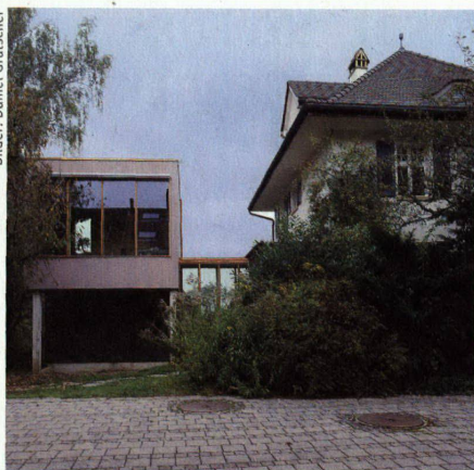
Der zweigeschossige Holzbau ist mit einem gläsernen Gang an den Altbau angedockt. Beide Teile bleiben eigenständig
