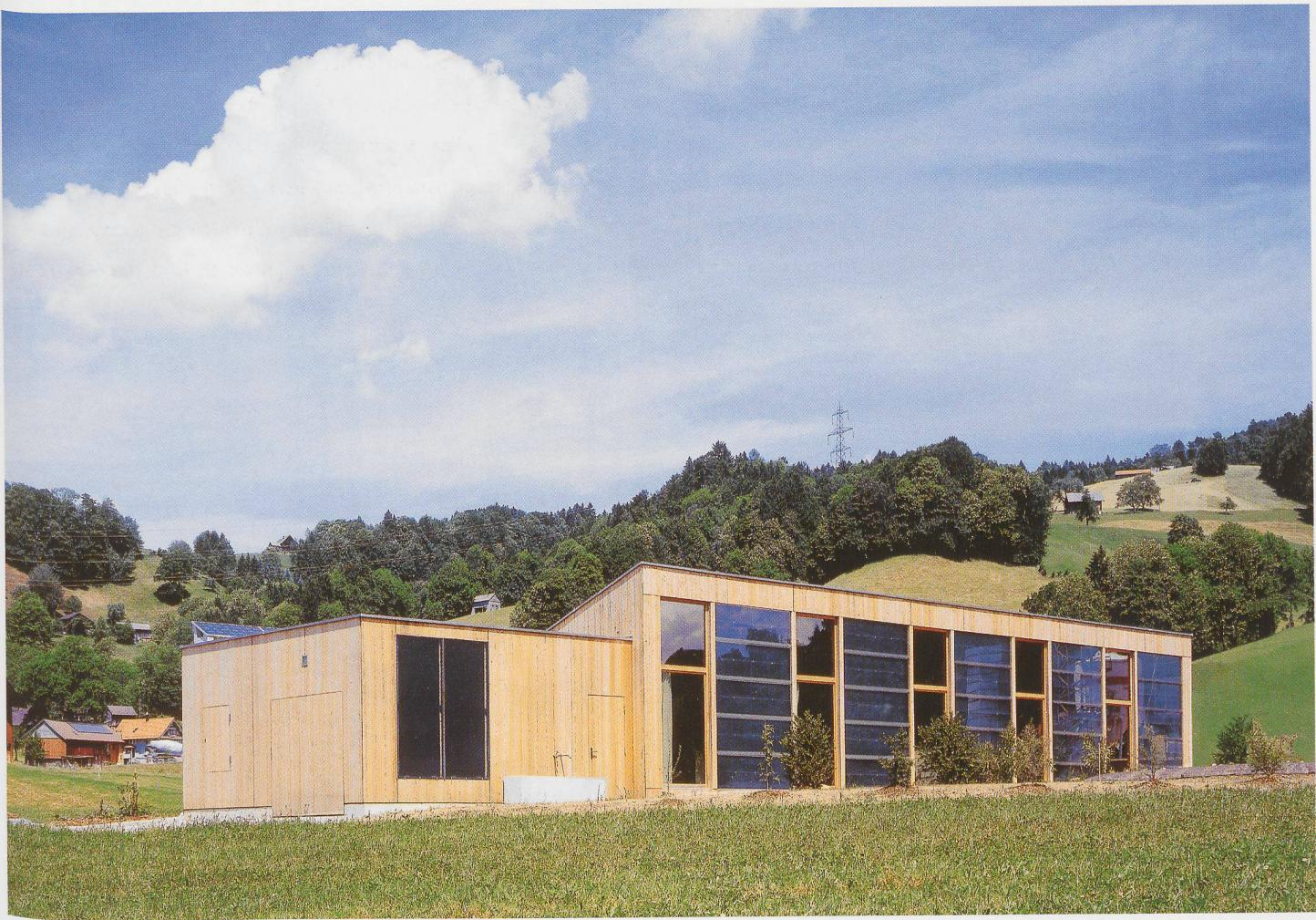
Die Hauträume des Solarhauses III in Ebnat-Kappel sind gegen Süden gerichtet. Die Südfront ist zu 38 Prozent verglast und zu 62 Prozent mit einer neu entwickelten Solarwand versehen. Die Eigenenergieversorgung liegt bei 95 - bis 100 Prozent; das Haus ist 15 Mal energieeffizienter als der Minergiestandard und 47 Mal effizienter als der SIA-Grenzwert.
