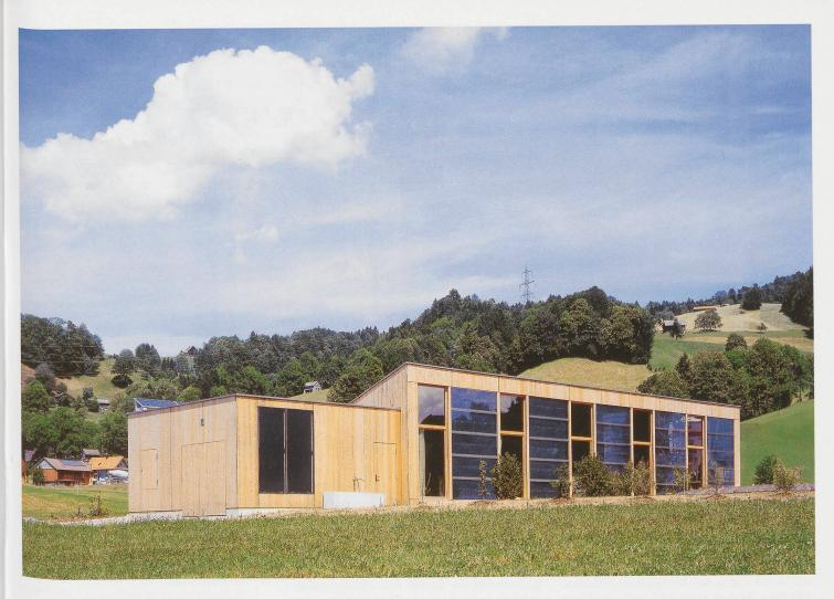
Die Haupträume des Solarhauses III in Ebnat-Kappel sind gegen Süden gerichtet. Die Südfassade ist zu 38 Prozent verglast und zu 62 Prozent mit einer neu entwickelten Solarwand versehen. Die Eigenenergieversorgung liegt bei 95 -bis 100 Prozent; das Haus ist 15 Mal energieeffizienter als der Minergiestandard und 47 Mal effinzienter als der SIA-Grenzwert
