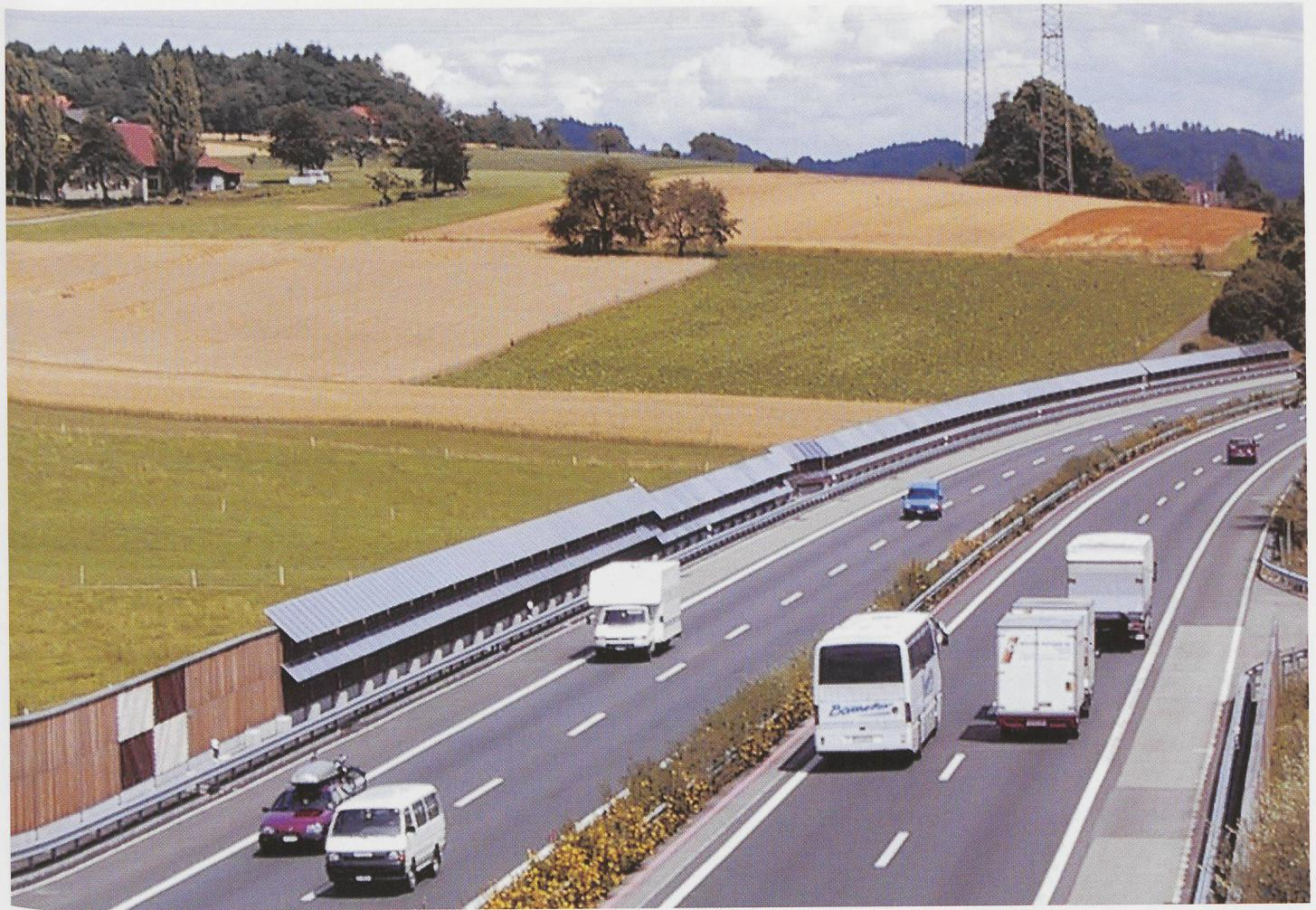
Die IG Solar Safenwil hat entlang der A1 eine 80-Kilowatt-Photovoltaik-Netzverbundanlage installiert
