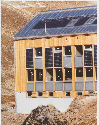
Die Keschhütte liegt in den Albula-Alpen auf 2630 Meter über Meer. Sie nutzt aktive und passive Solartechnologie für Heizung, Beleuchtung, Warmwasser und zum Kochen
