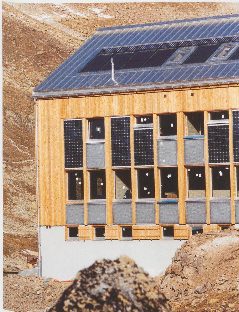
Die Keschnhütte liegt in den Albulal-Alpen auf 2630 Meter über Meer. Sie nutzt aktive und passive Solartechnologie für Heizung, Beleuchtung, Warmwasser und zum Kochen
