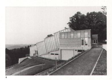
Antrieb und die Wagengrube. Nur der betonierte Kommandoraum ragt über die Erdoberfläche hinaus. Auf dieses Fundament, das auch die Seilspannung aufnimmt, stellt Hunziker eine Leichtkonstruktion aus Stahl und Holz. Das hat auch logistische Gründe. Der Bauplatz war schwer zugänglich und die Bauzeiten waren knapp. Darüber hinaus musste gebaut werden, während die Bahn noch in Betrieb war. Nur zwischen dem 23. Februar und den 1. Juli 1999 stand die Bahn still.
