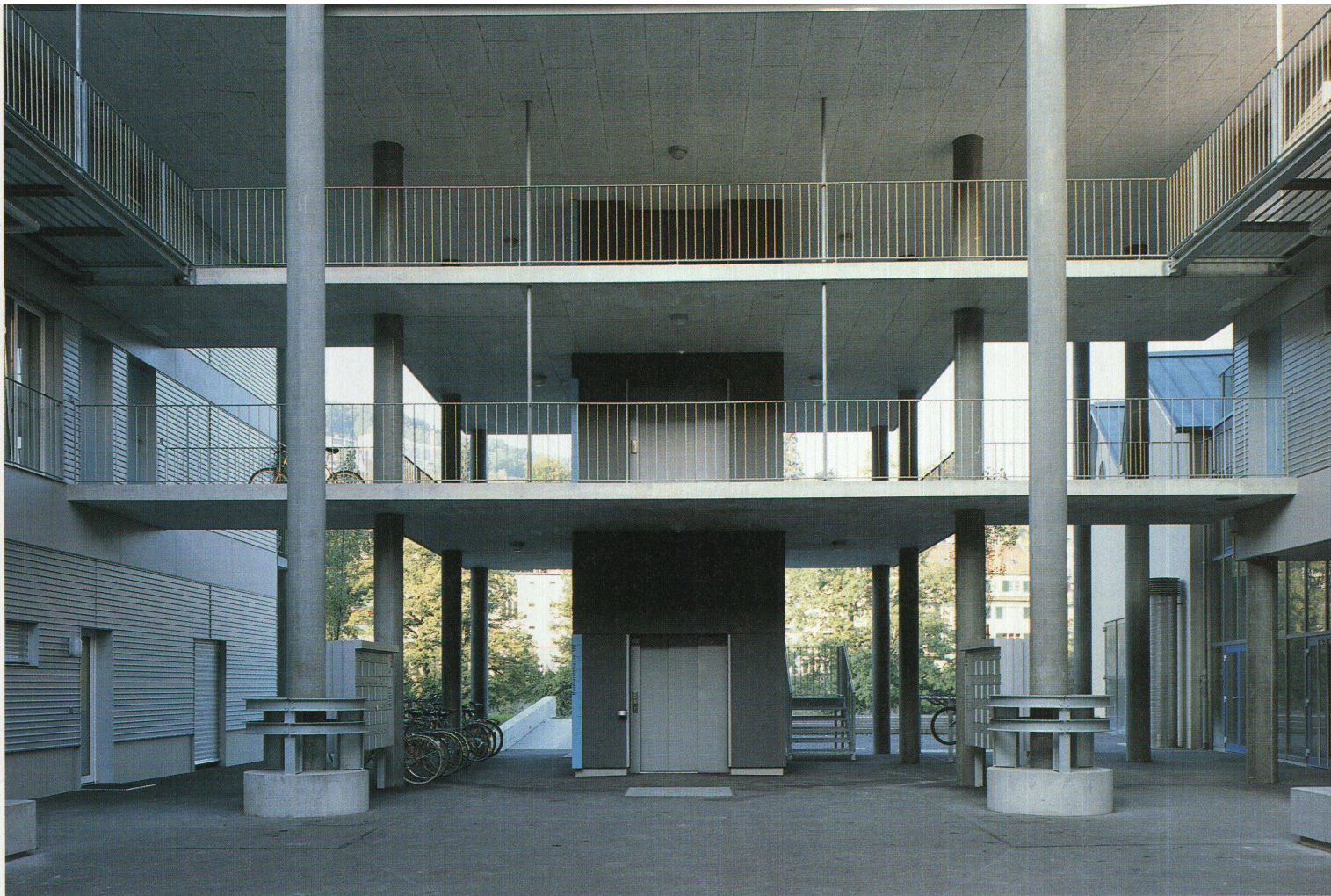
«Flussfenster» im Erschliessungshof. Rechts die Mehrzweckhalle
