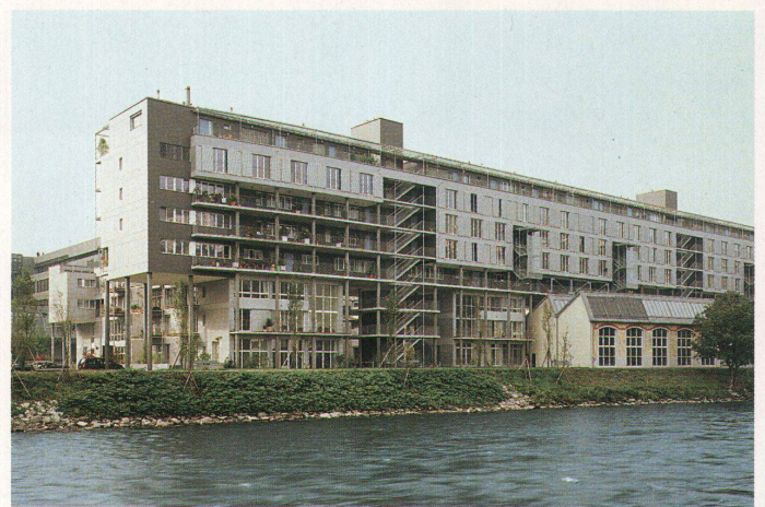
Limmatwest Flussseite. Der Wohntrakt ist auf dreigeschoss hohen Säulen aufgeständert. Rechts der Mehrzwecksaal, alles, was von der einstigen Fabrik übrig blieb
