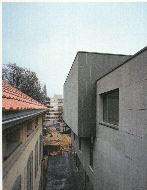
Hangseitig trennt ein Abstand das Gebäude vom gewachsenen Fels und den bestehen- den Annexionen
