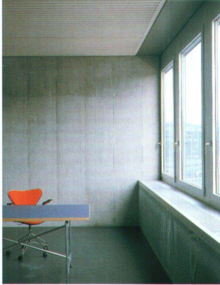
Die Büroräume sind schmucklos und funktional: Weisszementplatten an der Decke reflektieren das Licht und dämmen den Schall. Die Hälfte der Decken-Betonfläche ist Speichermaasse für die Nachtauskühlung
