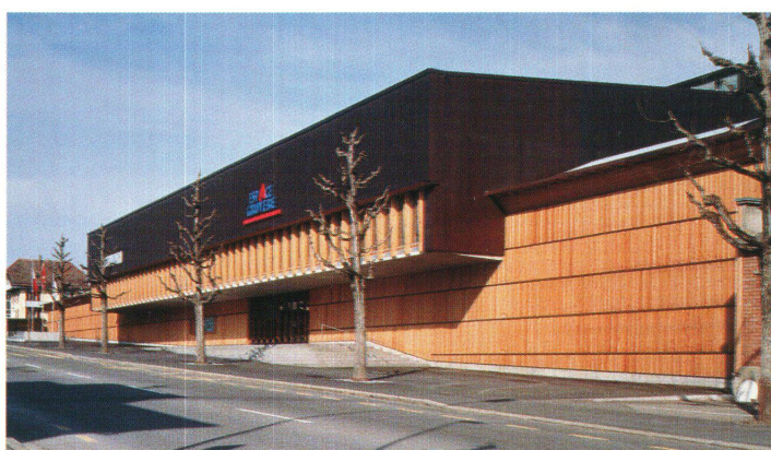
Auf der Strassenseite kragt der verglaste Restaurantriegel über den Eingang hinaus
