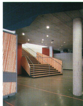
Eine der einläufigen Treppen, die von der Eingangshalle auf die Tribüne führt
