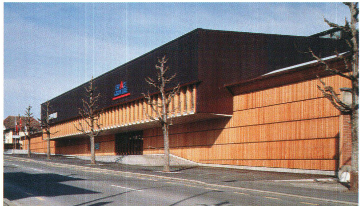
Auf der Strassenseite krägt der verglaste Resturantriegel über den Eingang heraus
