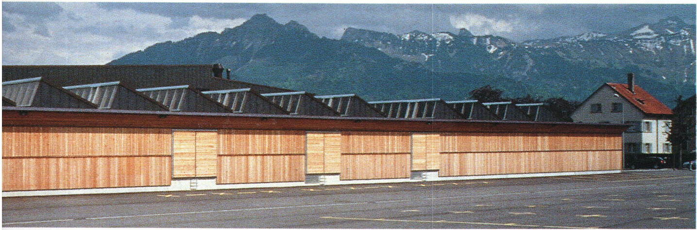
Das Sheddach stellt der natürlichen eine künstliche Zackenlandschaft entgegen. Die Eishalle ist mit schwarzem Kupfer ummantelt und in die Viehhalle hineingeschoben
