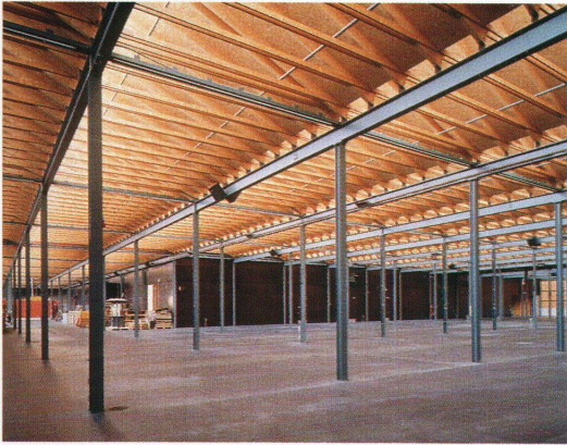
Die Viehmarkthalle ist eine einfache Stahlstützenkonstruktion, auf der ein Holzsheddach liegt
