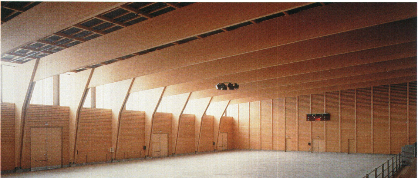
Die Eishalle mit ihren gewaltigen Querbindern erweitert die Ausstellungsfläche des Espace Gruyère von 6000 auf 8000 Quadratmeter
