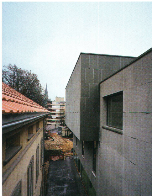
Hangseitig trennt ein Abstand das Gebäude vom gewachsenen Fels und den bestehen- den Annexbauten
