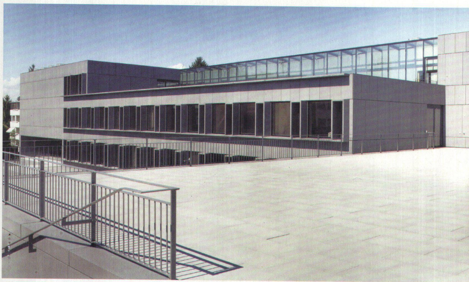
Im Vordergrund das Dach der Turnhalle, das die Schüler als Pausendeck nutzen, dahinter der viergeschossige Haupttrakt mit dem Abschluss der grossen Glasvitrine
