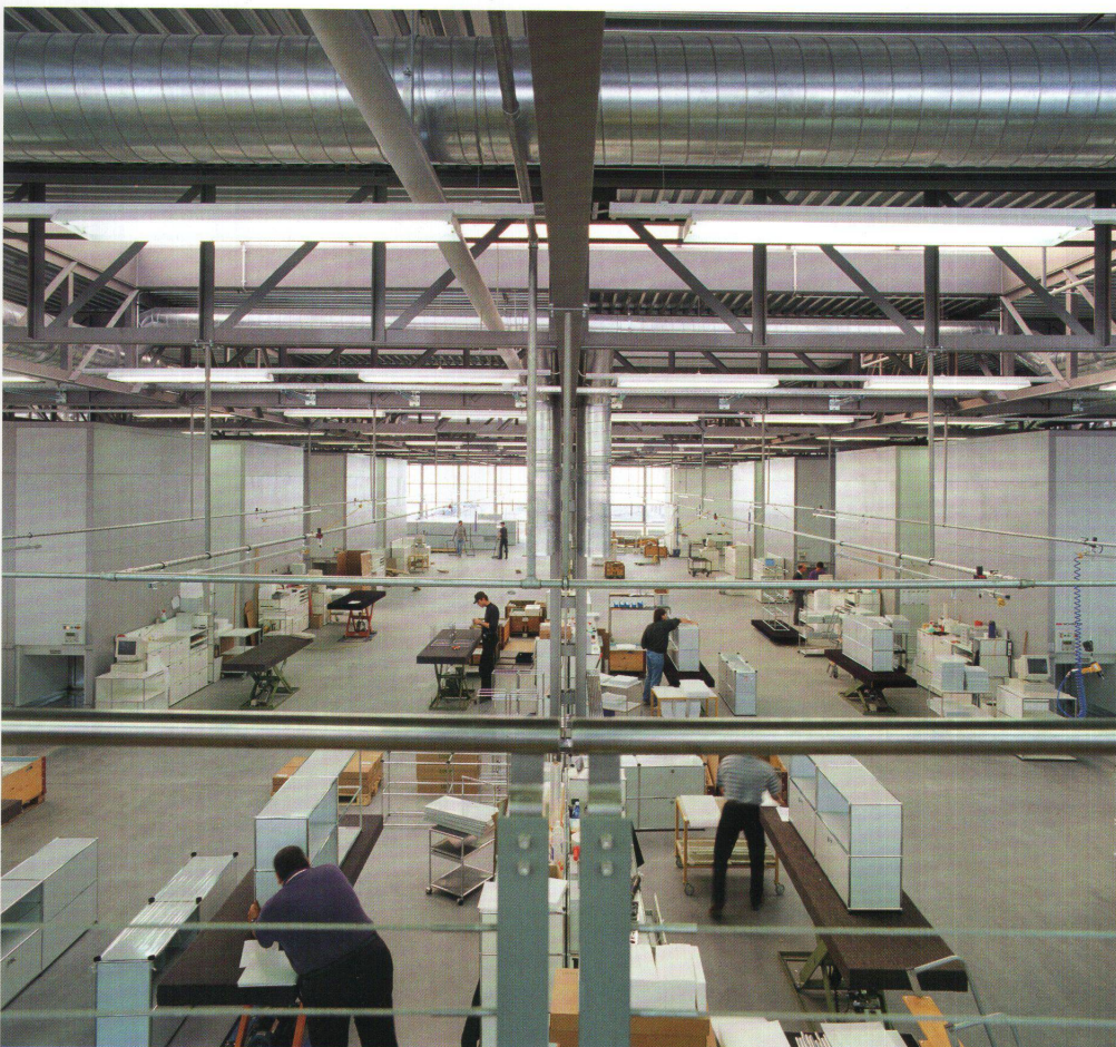
Zwischen 1961 und 1963 entstand das erste Stahlbausystem mit Namen «Maxi», ein Baukasten-System, mit dem man eingeschossige Hallen mit grossem Stützenabstand errichten konnte. usm wandte dieses System erstmals bei der eigenen Betriebsanlage in Münsingen an.
