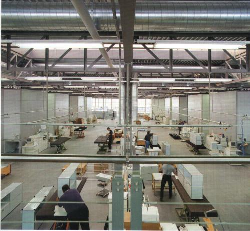
Zwischen 1961 und 1963 entstand das erste Stahlbausystem mit Namen «Maxi», ein Baukasten-System, mit dem man eingeschossige Hallen mit grossem Stützenabstand errichten konnte. usm wandte dieses System erstmals bei der eigenen Betriebsanlage in Münsingen an.
