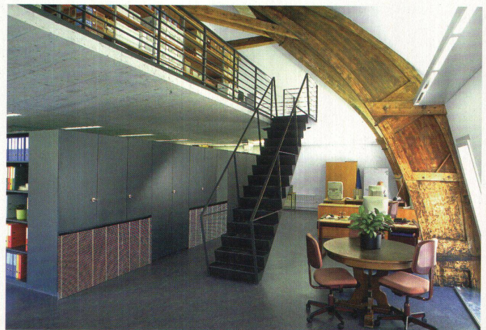
Büros auf dem ehemaligen Heuboden, gut sichtbar die alten Brettschichtträger. Die Galerie aus Beton dient als Lager und Raum für die Haustechnikzentrale
