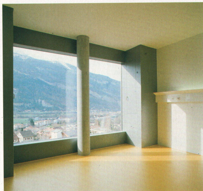
Krankenraum. Das Fenster ist als Erker ausgebildet, rechts im Aluminiumkasten der Lüftungsflügel
