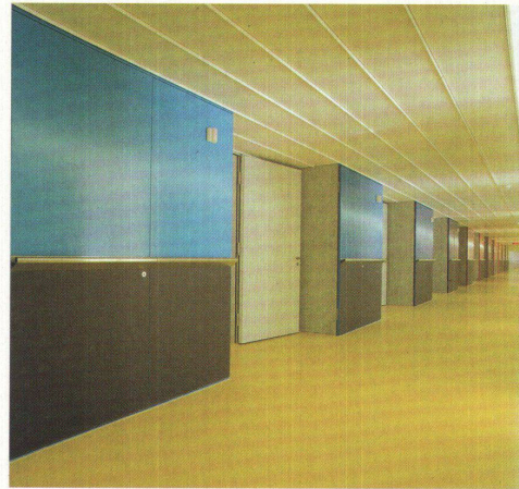
Normalgeschoss des Bettenhauses, Korridor. Gut sichtbar die zwischen den Stützen eingelassenen Schränke mit der Haustechnik
