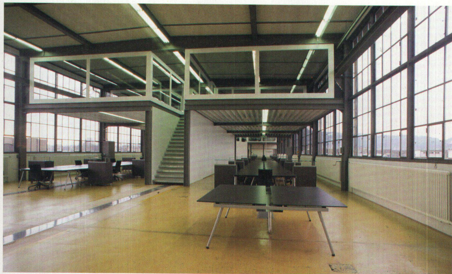
Die eingebaute Galerie in der Montagehalle
