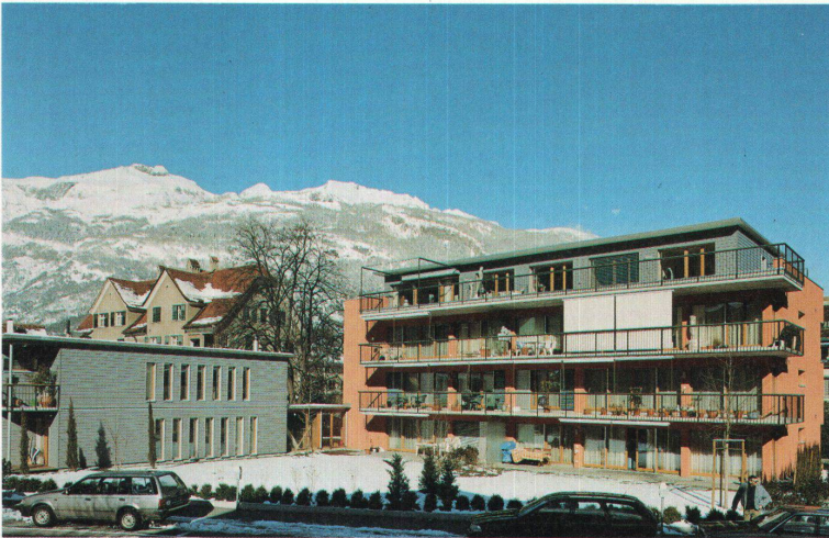
Stadtwohnungen in Chur. Links das Einfamilienhaus, rechts davon die Eigentumswohnungen
