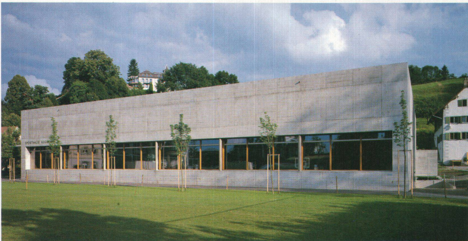
Doppelturnhalle mit drei Schulzimmern in Rheineck
