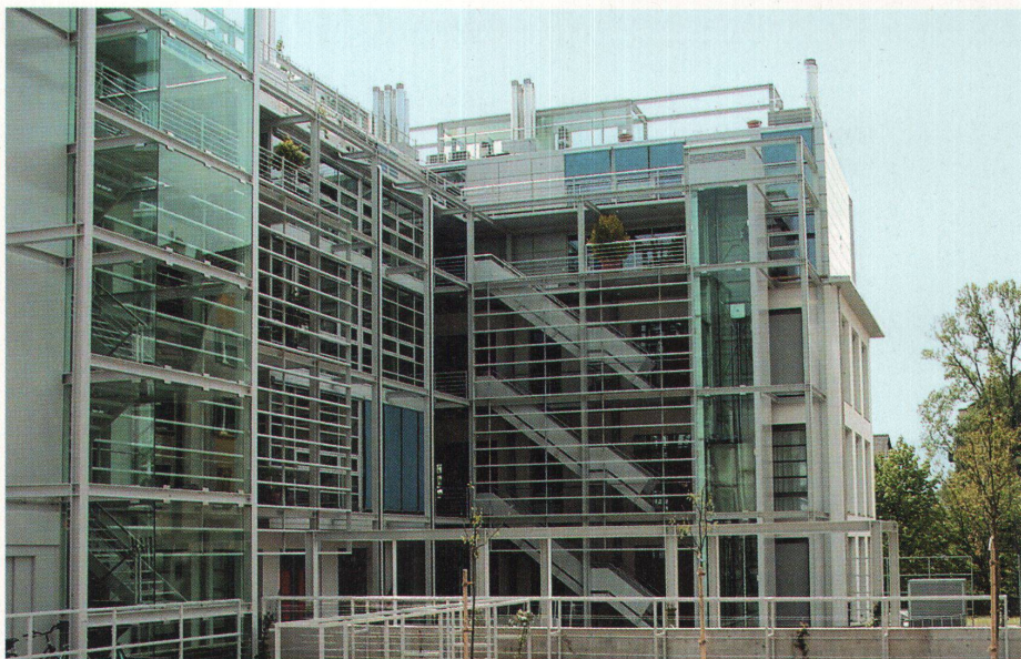
Der Hof mit den Wohnungerschliessungen
