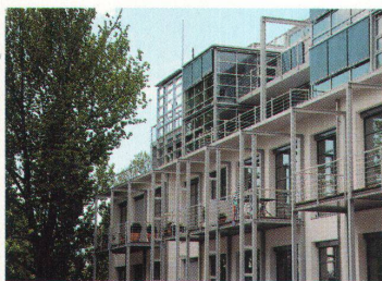
Frontfassade. Wer hier aus dem Fenster schaut, sieht auf Park und Limmat
