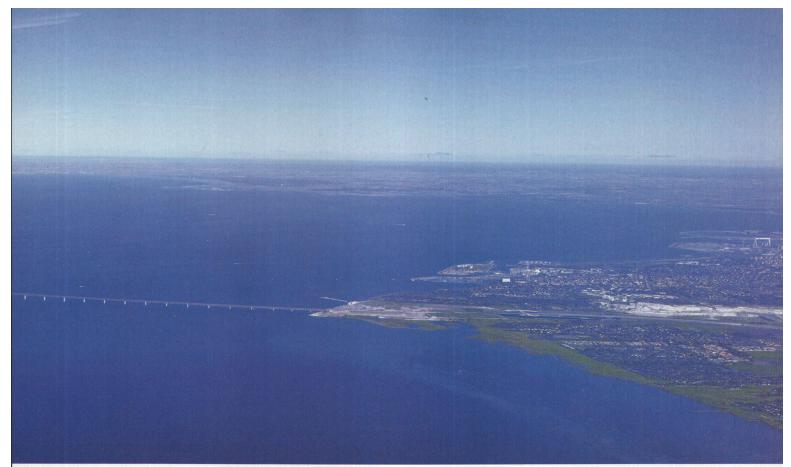
Die Brücke über den Öresund: links die künstliche Insel mit dem Portal zum Unterwassertunnel: Die östliche Zufahrtsbrücke ist 3000 m lang, die westliche 3700 m. Die Spannweiten zwischen den insgesamt 51 Pfeilern betragen 120 bis 140 m. Die Hauptbrücke, eine 1100 m lange Schrägkabelbrücke, hat eine Spannweite zwischen den Pylonen von 490 m. Die Fahrbahn quert 57 m über dem Meeresspiegel die Schifffahrtsrinne. Die Pylonen sind 204 m hoch
