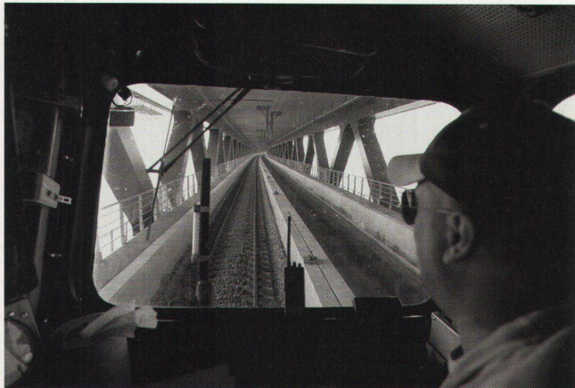
Das Eisenbahntrasse verläuft in der unteren Brückenetage, im Fachwerkträger
