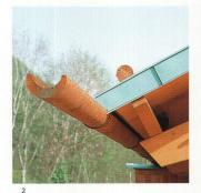
Das Dach als konstruktiver Holzschutz
