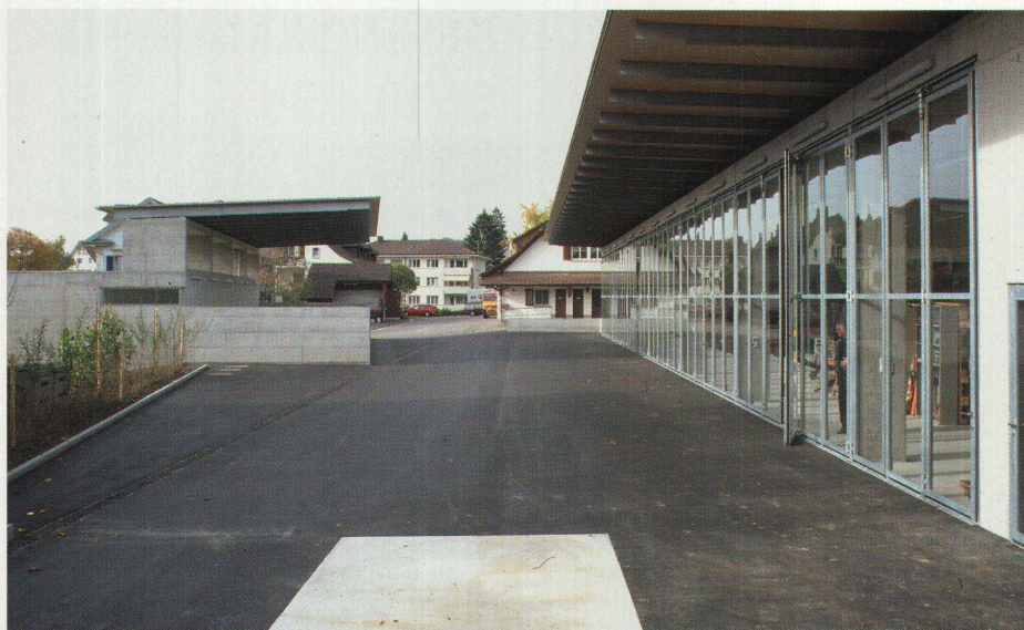
Links die Halle für die Energie- und Wasserversorgung, rechts für das Bauamt. Unter dem linken Vordach befindet sich die Abfallsammelstelle
