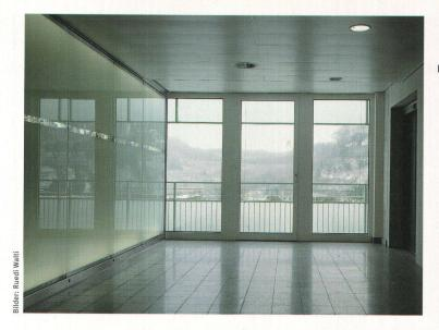
Die Fassadensanierung: Strukturglasplatten lassen die Isolation durchschimmern
