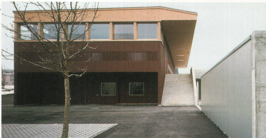
Untergeschoss und darüber liegender Bürotrakt aus Beton in Holz verkleidet, die dahinter liegende Halle und das Vordach aus Holz. Rechts die Sammelstelle
