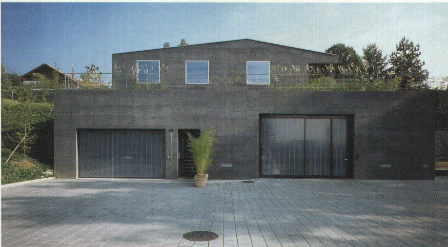
Der schwarz eingefärbte Sichtbeton und die minimalisierten Dachkanten heben das Haus von der Umgebung ab
