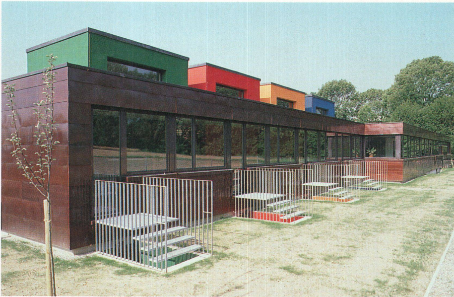
Die farbig gestalteten Dachaufbauten verweisen auf die Schulzimmer im Obergeschoss
