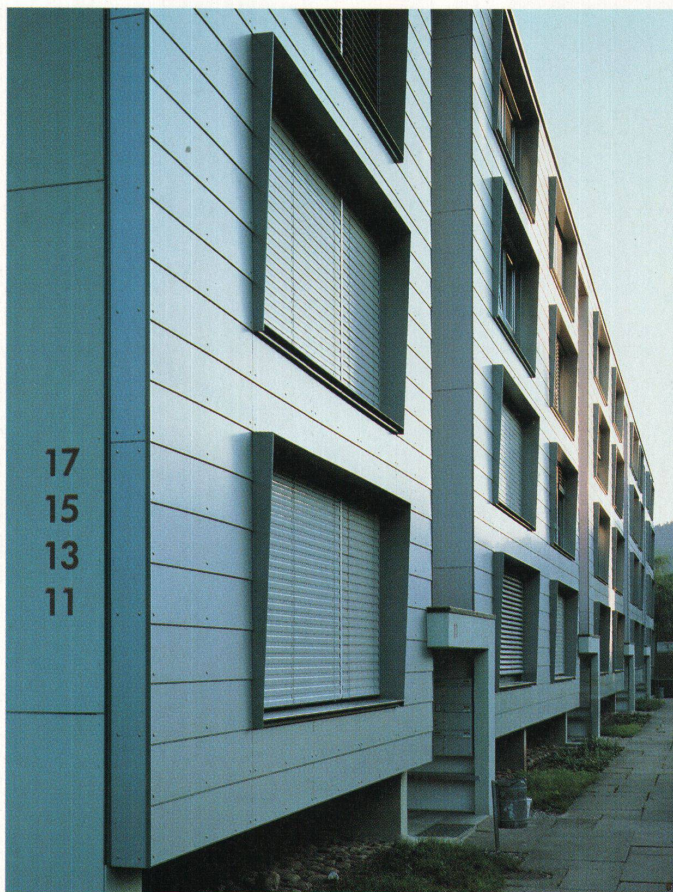
Stahlzargen schützen die Holz/Metall-Fenster auf der Eingangsseite. Indem sie die Form der Metallschweller der Gartenfassade wieder aufnehmen, schaffen sie eine Verbindung zwischen den beiden Fassaden
