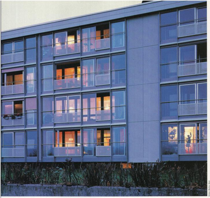
So weit wie möglich vorgefertigt, so schlicht wie möglich – und darum gut: Die verglasten Balkone der Gartenfassaden sind das Resultat der Zusammenarbeit zwischen Architekten und Fassadenbauern
