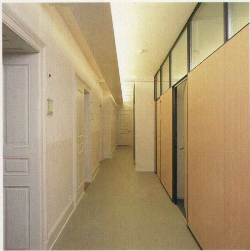
Der Korridor erzählt die Geschichte des Hauses: links die massiven Mauern mit den alten Holztüren, rechts die hellen Trennwände zu den neuen Büroräumen
