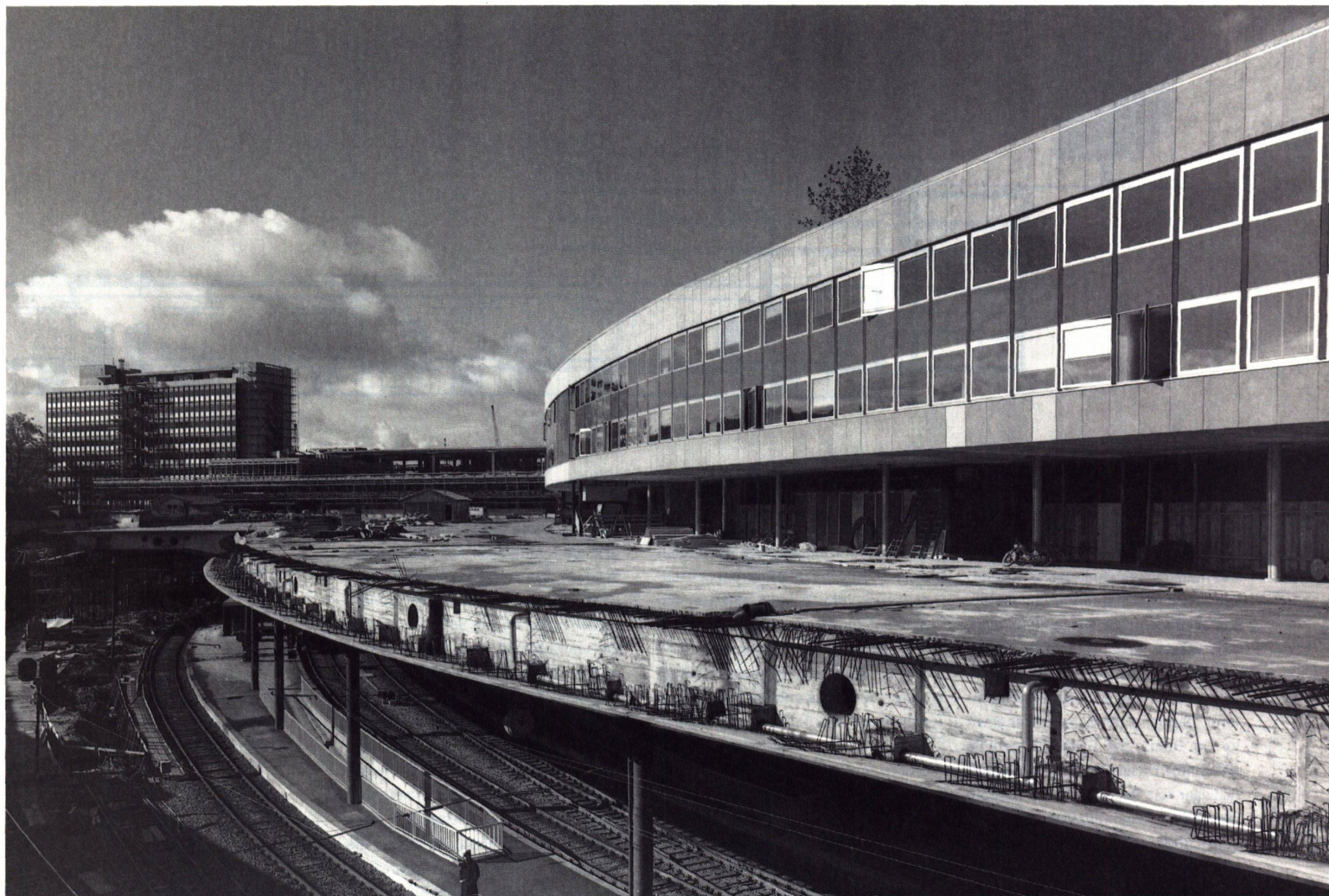
Der Perrondeckel 1964. Der Verlauf des Parkhauses entspricht der darunter liegenden Gleiskurve
